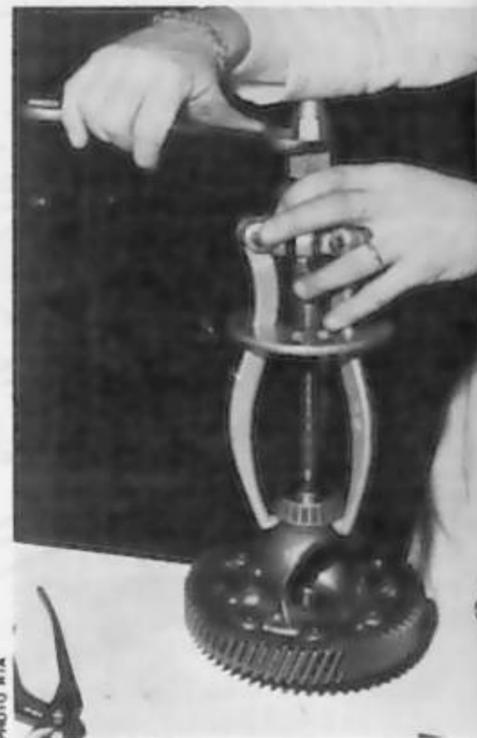
Extraction des roulements de différentiel
